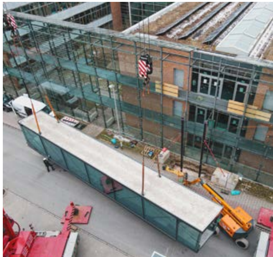
Der Einhub zwischen den Bestandsgebäuden erfolgte mit zwei Autokränen.
