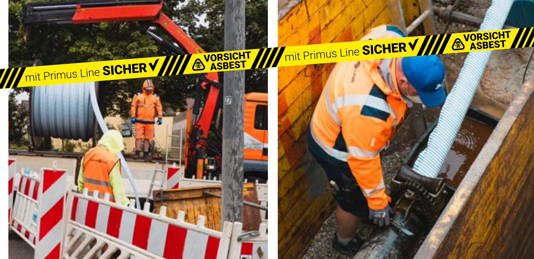
Eines der Az-Projekte in diesem Jahr: Die Instandhaltung einer 2,4 Kilometer langen Transportleitung DN 200 in der näheren Umgebung in Luhe-Wildenau südlich von Weiden in der Oberpfalz.
