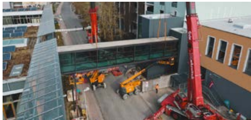
Der Einhub zwischen den Bestandsgebäuden erfolgte mit zwei Autokränen.
