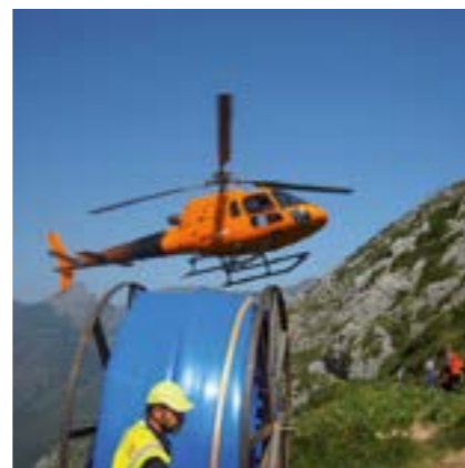
Besonderheit beim ersten Projekt in Spanien: Liner und Installationsmaterialien wurden per Hubschrauber eingeflogen.
