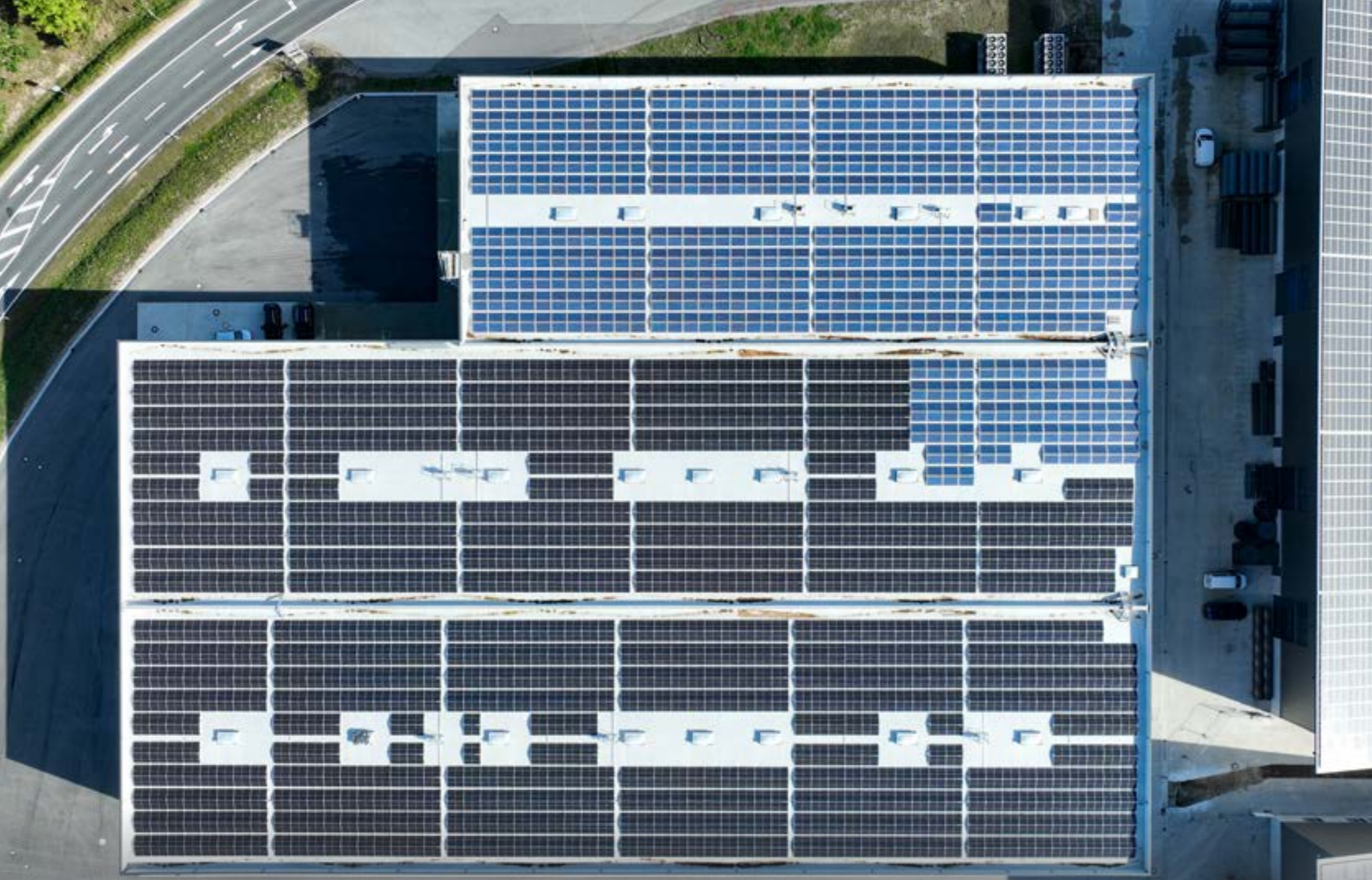
PV-ANLAGE AUF DEM NEU ERRICHTETEN PRIMUS LINE LOGISTIKZENTRUM IN CHAMMÜNSTER.
