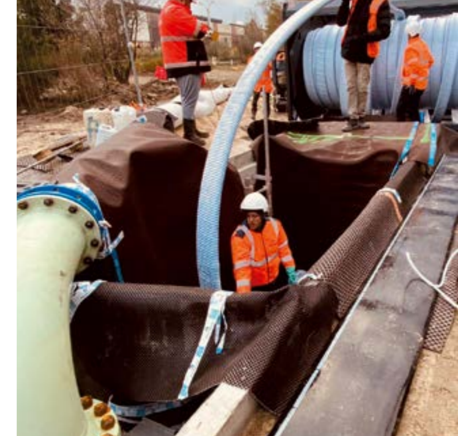
Der Primus Liner zu Sanierung der Sole-Transportleitung läuft von der Trommel in die entsprechende Baugrube. Links im Bild das Verbindungsstück für den Bypass.
