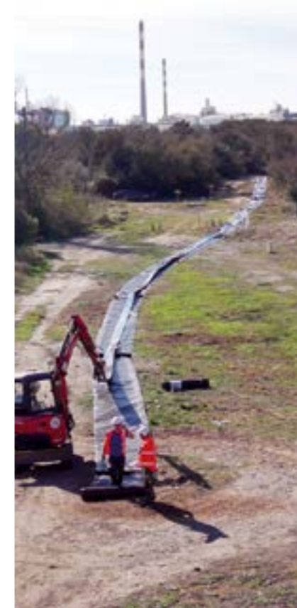
Primus Line® Overland Piping wird neben dem bestehenden Wirtschaftsweg verlegt.
